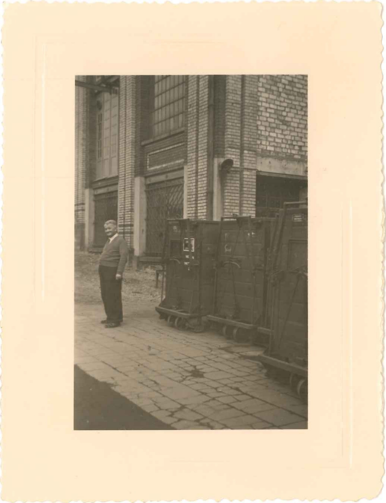
Ernest Durr dans la cour du bâtiment, devant les containers SNCF (Prêt B. Borzig)
